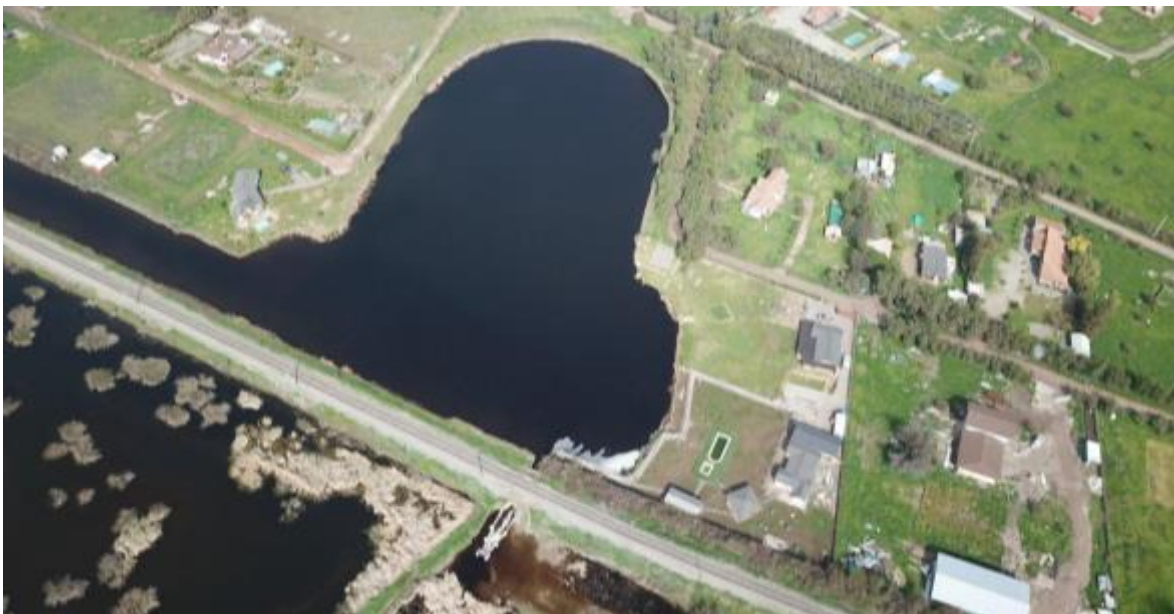
Fotografía 12 Modificación de cauce, sector Lo Fontecilla.
