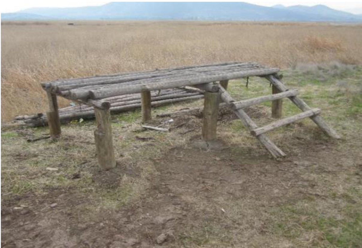
Fotografía 18 Registro de vandalismo en el sector del mirador de Cerámicas Santiago
